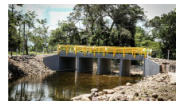
Nuevo box culvert y obras de mitigación del riesgo en Restrepo, entregó Gobernadora Rafaela Cortés. 9 septiembre 16, 2024
